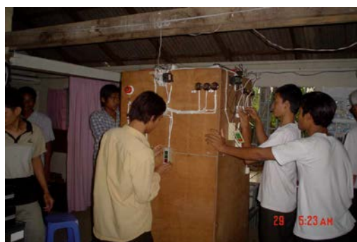
Les élèves pratiquent bobinage et installation électrique (va-et-vient, Timer, compteurs, télérupteurs,...schéma...)
