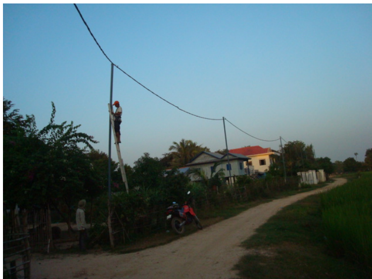
Alimentation à 220V. Ligne de 1km 500. Puissance 2Kw
