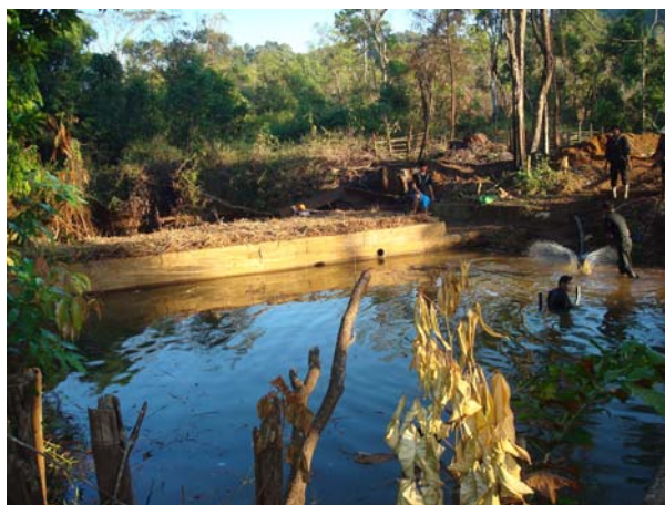
Un petit barrage en ciment pour un plan d'eau agréable et pour l'électricité
