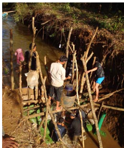
Monter le barrage avec des sacs de terre pour élever la hauteur d'eau
