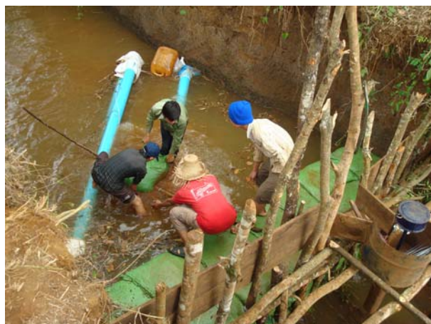
Monter le barrage avec des sacs de terre pour élever la hauteur d'eau
