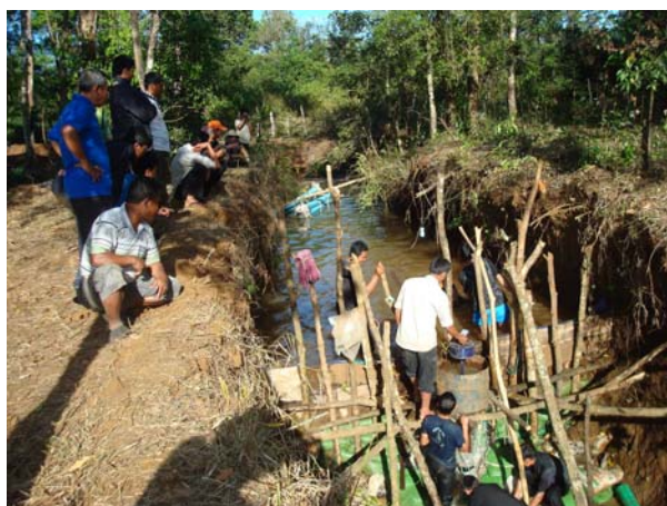
On n'a que 150V. Il faut allonger la hauteur de « fuite »
