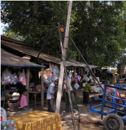
Pose d'un poteau CKN à Dambêr.
