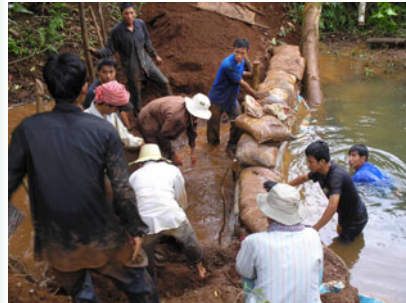
Construction d'un barrage à Mondulkiri
